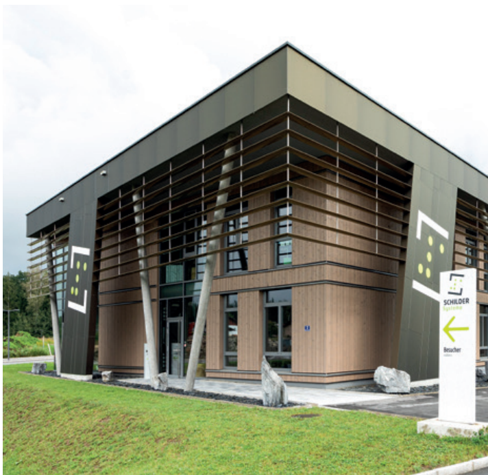
Betriebs- und Bürogebäude der Firma Schilder-Systeme in Bürmoos
